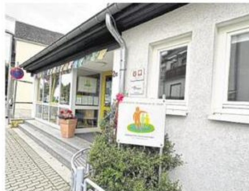
Die Bestandskita soll einem Neubau weichen.
